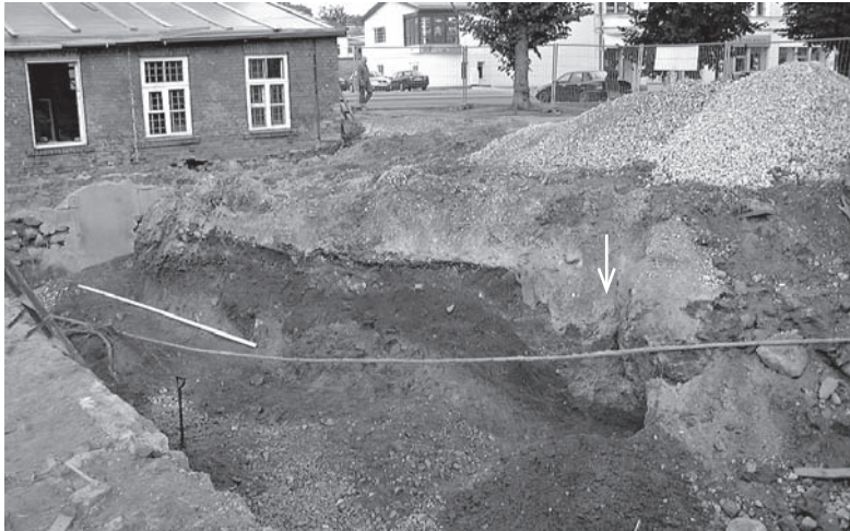
Joonis 5. Tartu tn 8A uue ärihoone vundamendisüvendi vaheprofiil. Näha on täidetud vallikraavi põhjaserv (noolega tähistatud).
