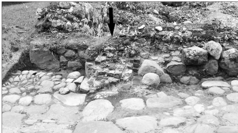
Joonis 2. Vaimulike hoone lääneseina väliskülg väljapuhastatult. Noolega on näidatud telliskonstruktsiooni.
