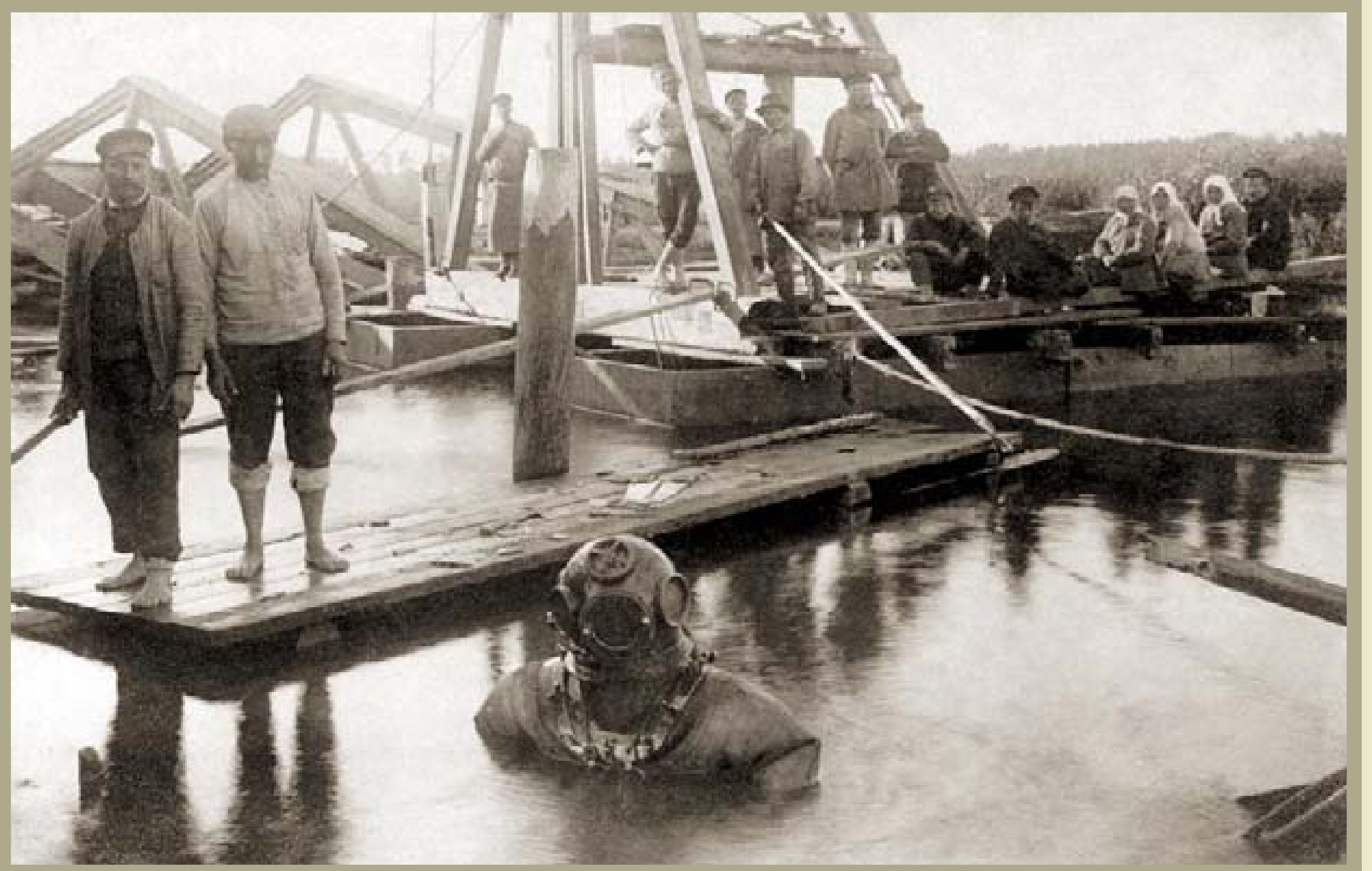
Punaste poolt õhitud Pimša jõe silla parandamine septembris 1919. Vaja on läinud tuukrit
